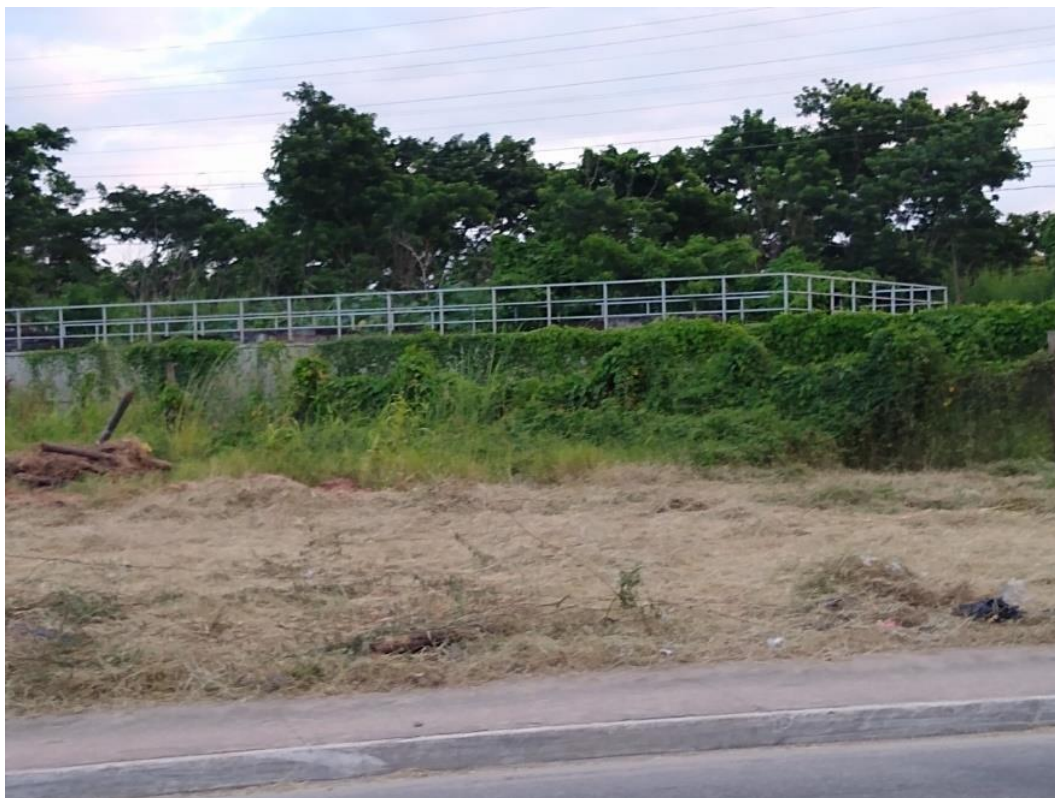
Figura 20: Estação de tratamento de esgoto inacabada e abandonada Fonte: arquivo de pesquisa
