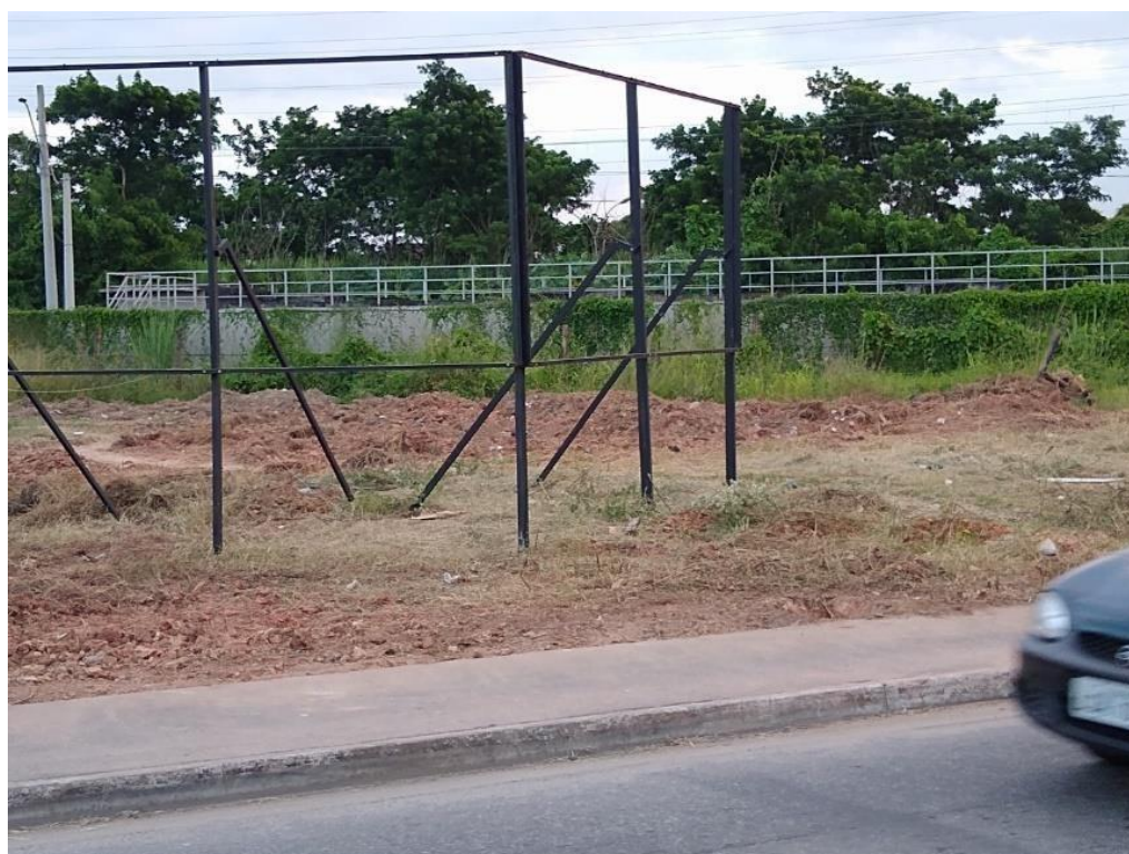
Figura 21: Estação de tratamento de esgoto inacabada e abandonada Fonte: arquivo de pesquisa
