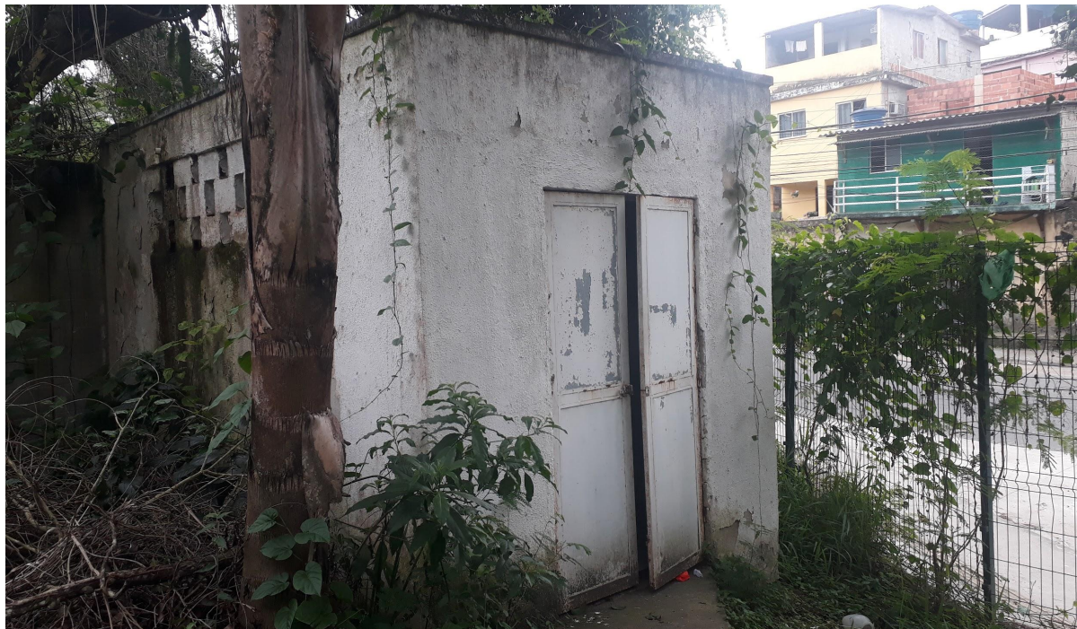
Figura 7: Abrigo temporário de resíduos sólidos
