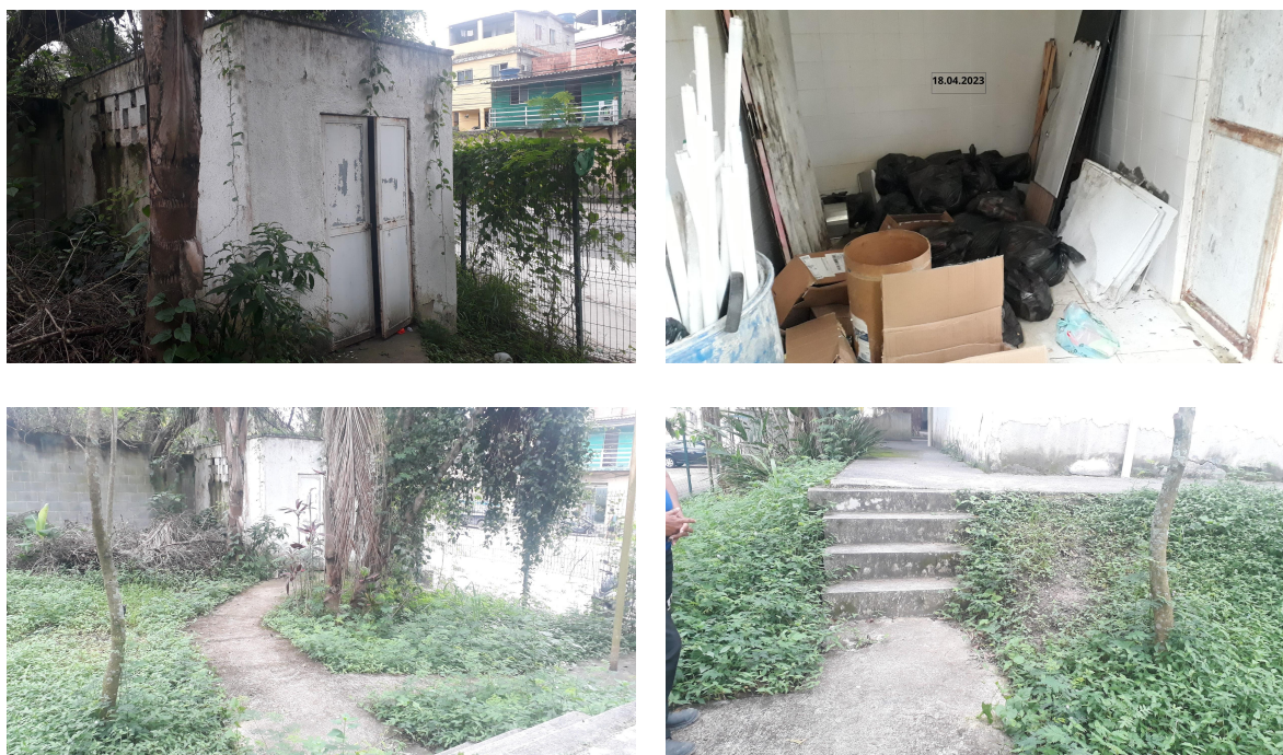
Figura 14: Portas e acesso ao abrigo temporário de resíduos sólidos
