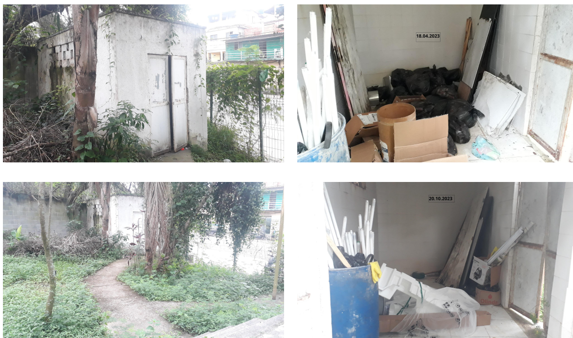
Figura 5: Abrigo de resíduos temporário
