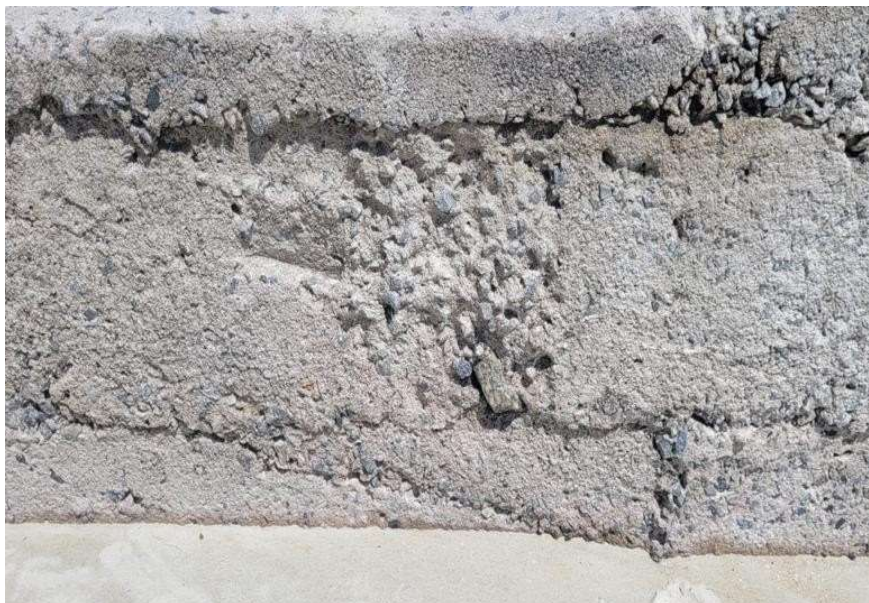
Figura 17: Ninhos de concretagem Fonte: Acervo da autora, 2023
