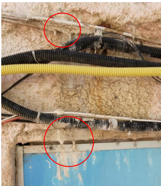
Figura 16: Lixiviação de sais e formação de estalactites Fonte: Acervo da autora, 2023
