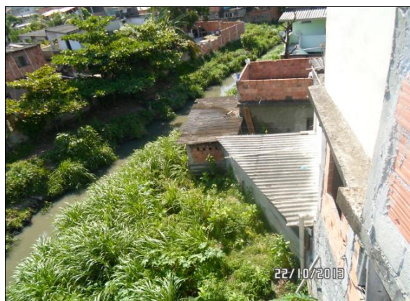
Figura 4 – Construções à margem do rio Imboçu, famílias na área de intervenção.
