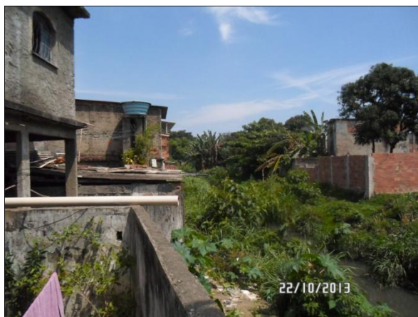
Figura 3 – Construções à margem do rio Imboçu, famílias na área de intervenção.
