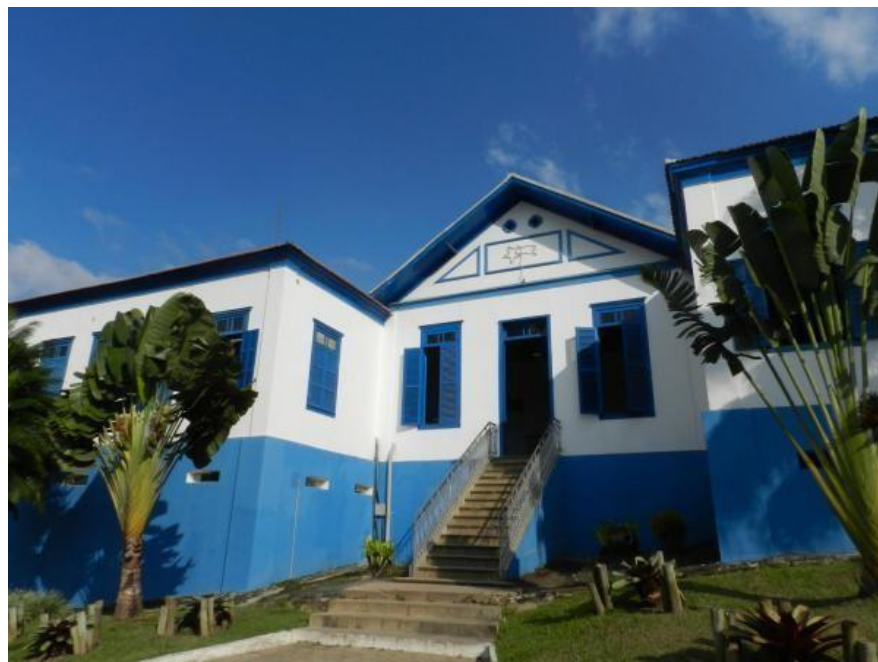
Foto 1 – Vista frontal do prédio administrativo do IFRJ CPIN
