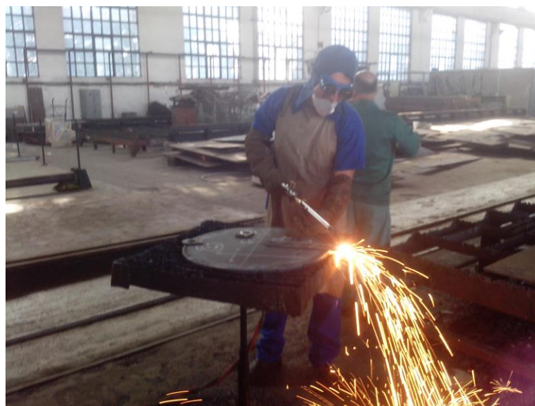
Figura 4 - Maçariqueiro operando o Maçarico Manual
