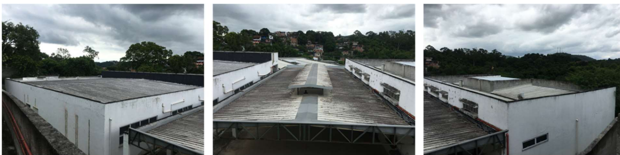
Figura 10 – Cobertura da Área 3
