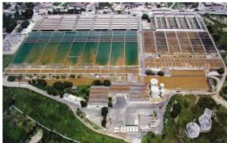
Estação de Tratamento de Água no Guandu — CEDAE
