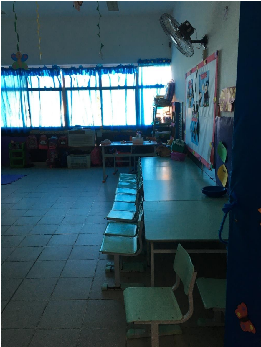
Figura 16 – Janelas da sala
