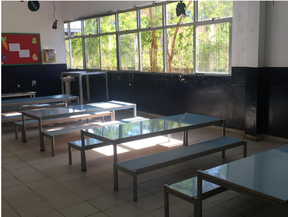
Figura 12 – Janelas do refeitório
