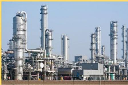
Figura 42. Torres de fracionamento de petróleo.<sup>7</sup>
